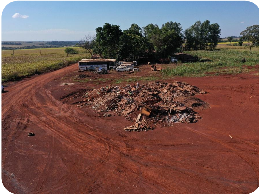
Figura 33: Disposição temporária inadequada de RCC no aterro de inertes de Laguna Carapã/MS.
